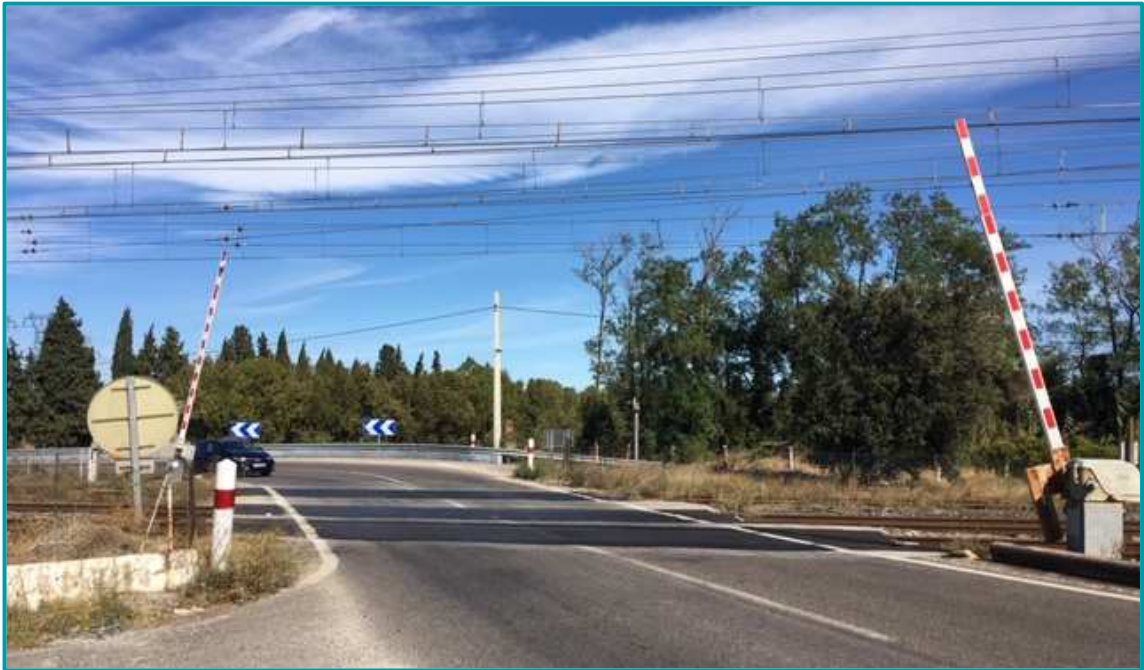
Vue depuis la route de la gare
